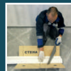
Монтаж лепного декора стр. 124
